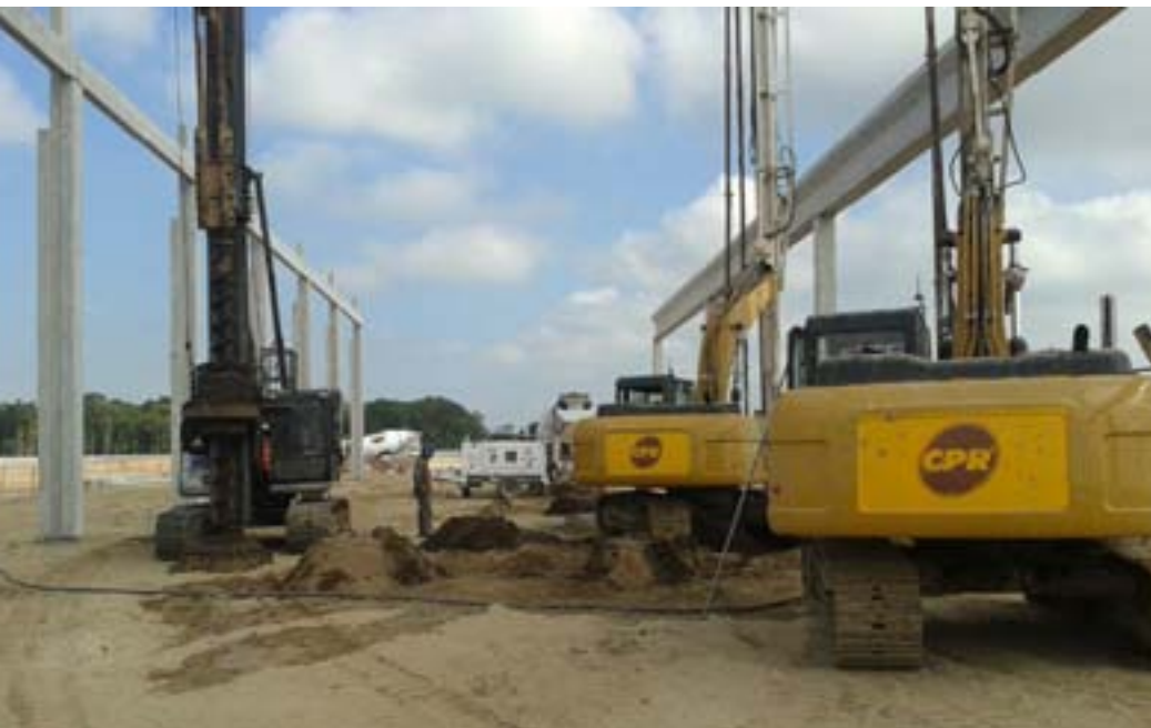
Três frentes de serviço de enrijecimento de solos foram necessários para atender o apertado cronograma da obra, e a grande área a ser tratada.
