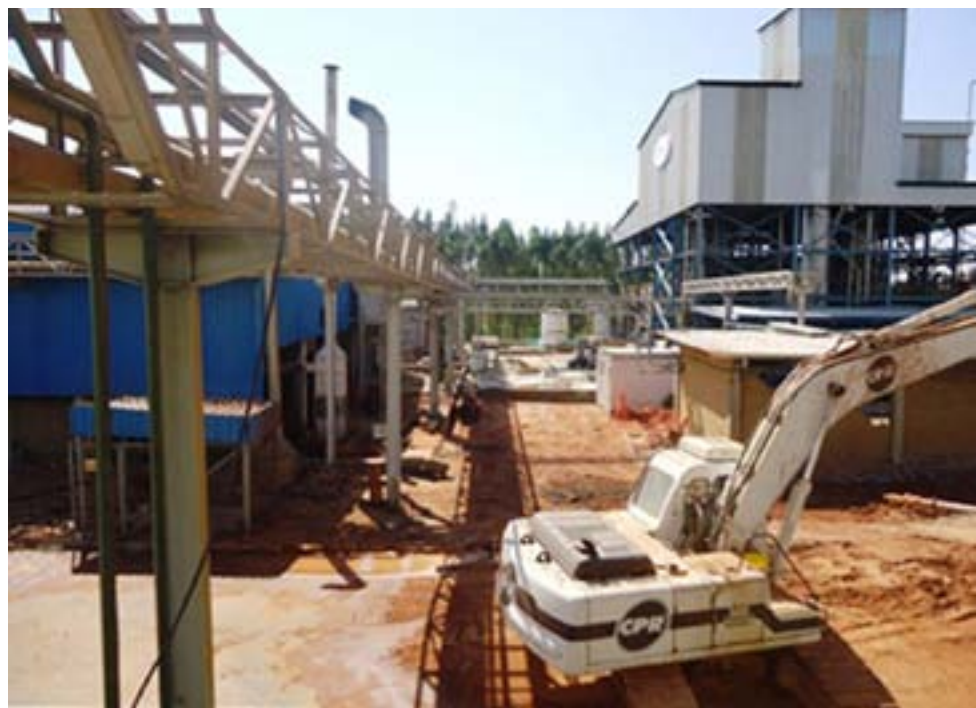
Serviços de CPR Grouting no enriquecimento dos depósitos de solo mole no interior do parque industrial.
