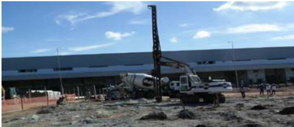
A seqüência de verticais com bulbos de compressão é visualizada pelos montinhos de geogROUT formados.
