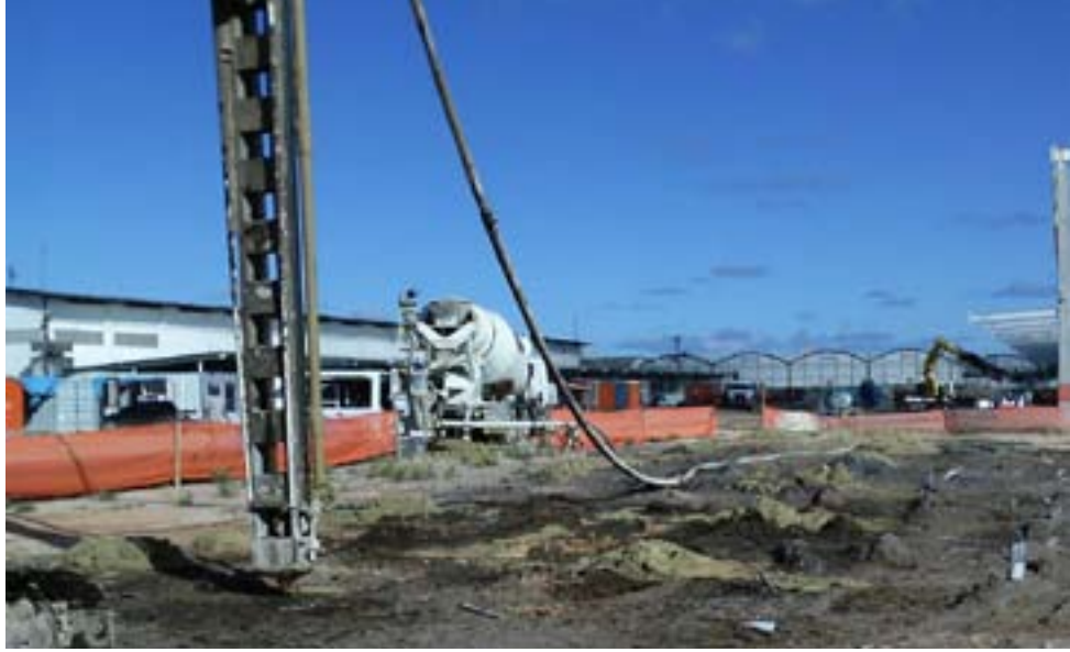
Compressão do solo mole, com geogROUT, estabelecendo altos níveis de resistência e rigidez no novo solo.
