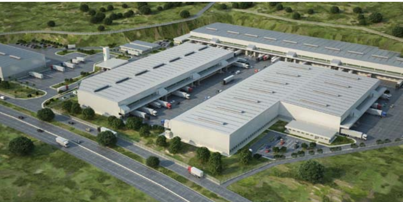
Galpão logístico da LOG Commercial Properties, Juiz de Fora, Minas Gerais.
