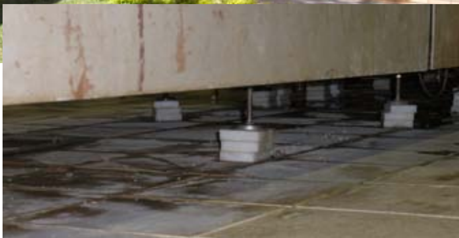
Pequenas placas de mármore eram utilizadas para renivelar os equipamentos.
