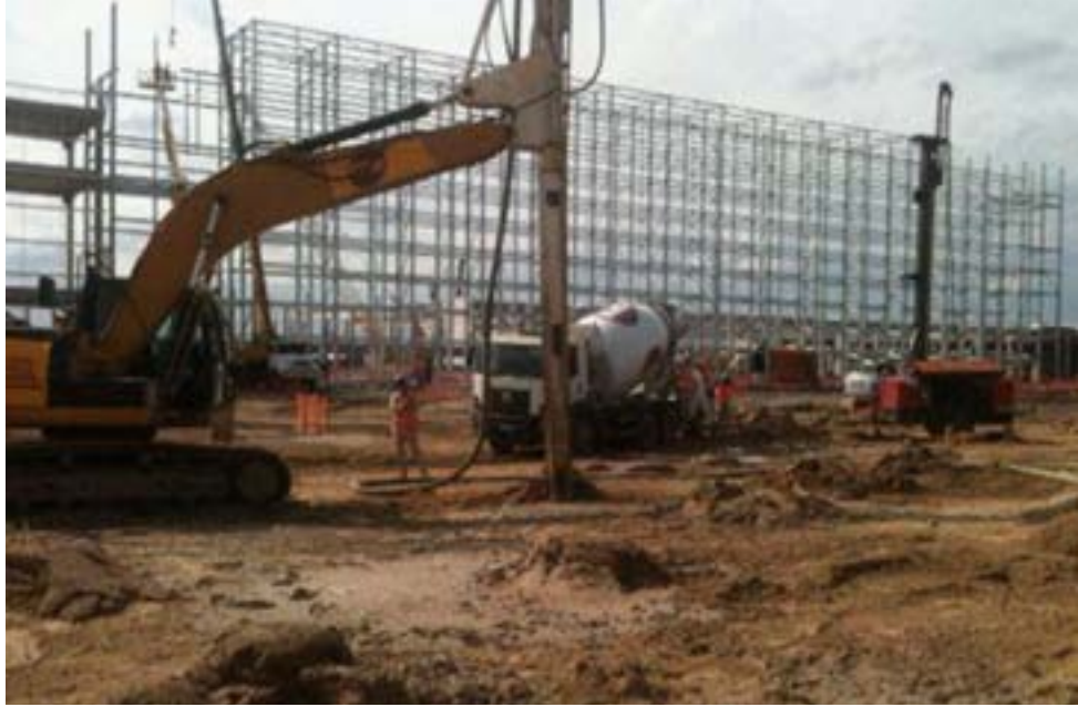
A modificação das características de solo mole para solo resistente, com a rapidez necessária que permitisse a imediata liberação do terreno, foi fundamental para a viabilização do projeto.
