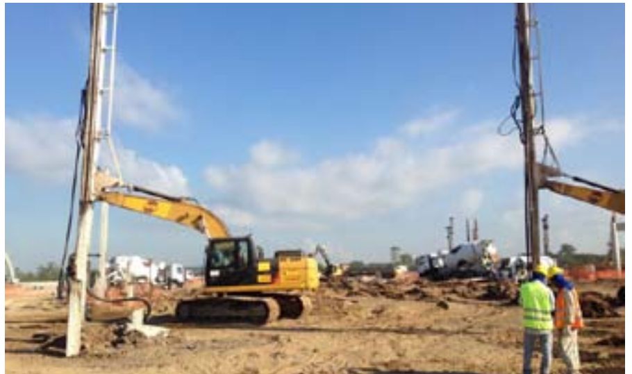
A moderna tecnologia CPR Grouting em uma área de galpão logístico, em Santa Catarina.
