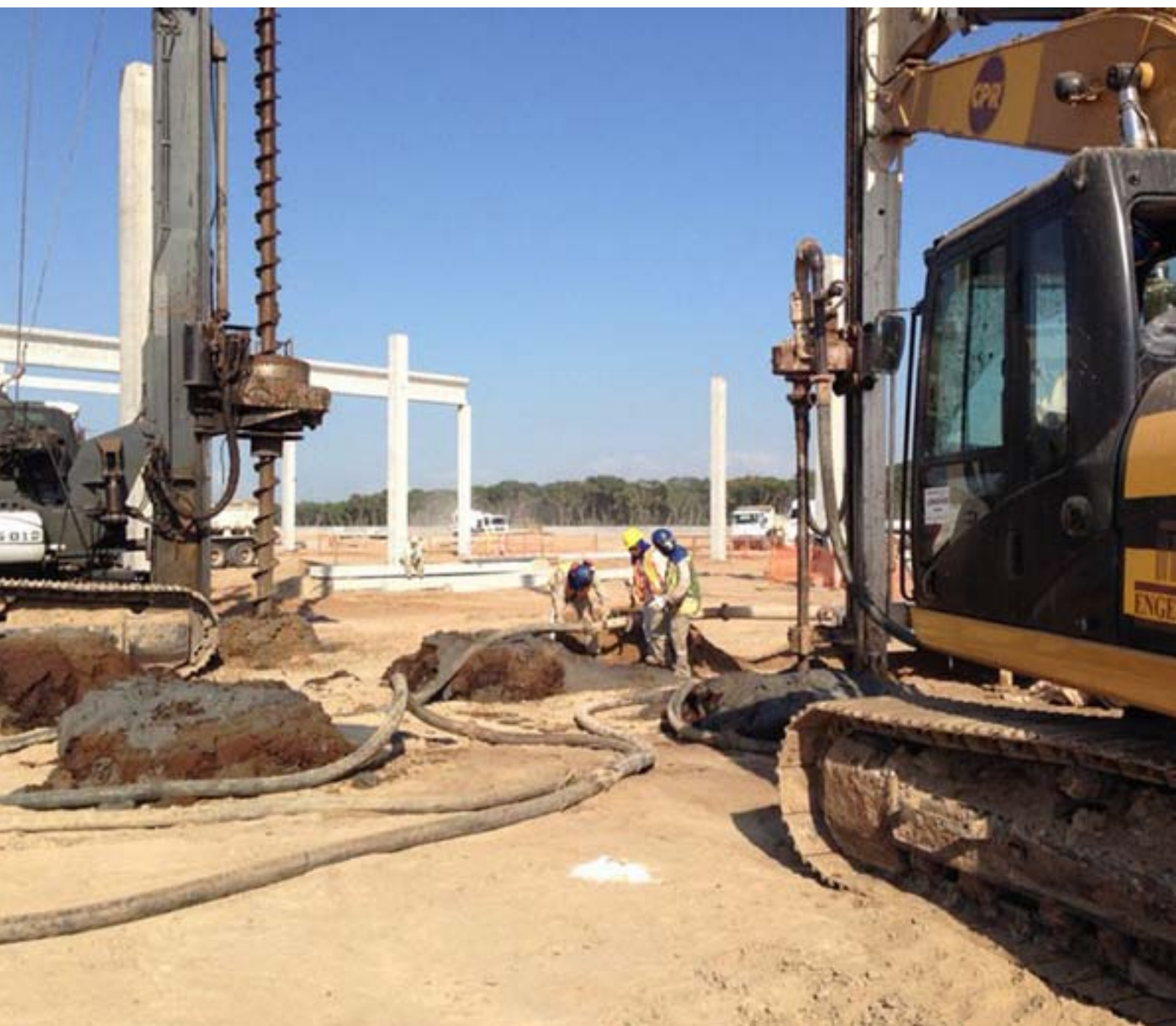
Serviços iniciais de pré-furo para ultrapassar camada de areia compacta superficial (cerca de 2m) de modo a ser acessar os depósitos de solo mole para posterior enrijecimento, na preparação do terreno para a fábrica Alemã de automóveis, em Araquari, Santa Catarina.
