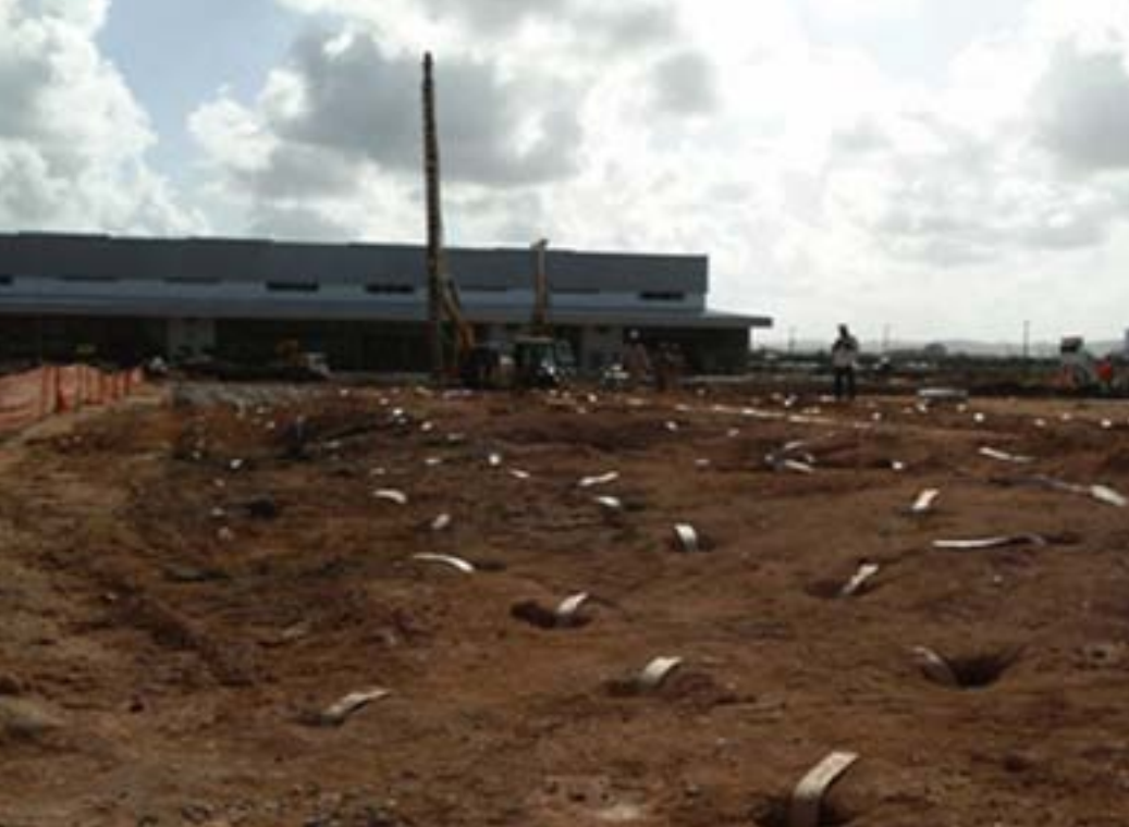
A primeira etapa do enrijecimento do solo: cravação do geodreno.
