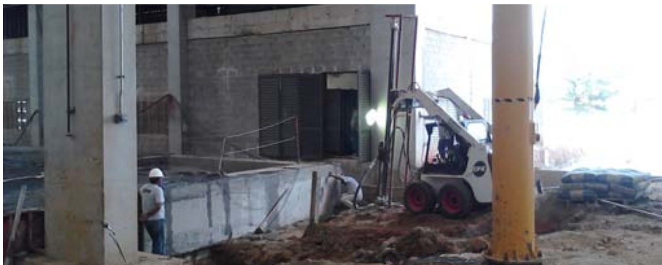
Execução de pré-furos necessários para se atingir cotas inferiores à ponta das estacas.
