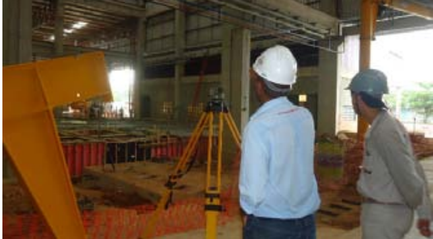
Monitoramento geotécnico constante do solo e da estrutura durante os serviços.
