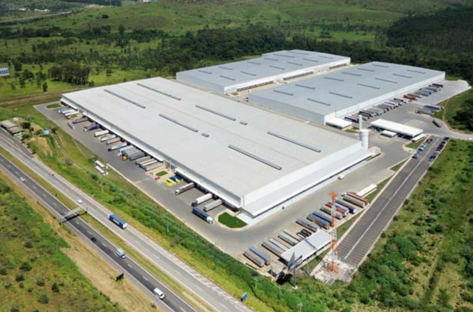
Galpão logístico Distribution Center Cabreúva, às margens da Rodovia Dom Gabriel Paulino Bueno Couto, SP.
