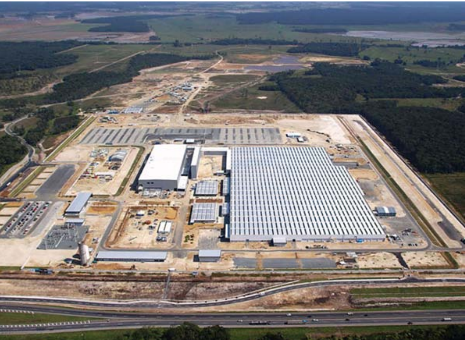
Obras em andamento do parque industrial automotivo, após o enrijecimento do solo.
