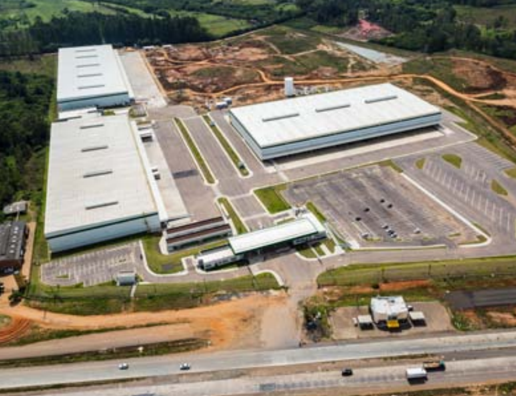
Galpão logístico da GLP - Global Logistics Properties em Gravataí, Porto Alegre, RS.
