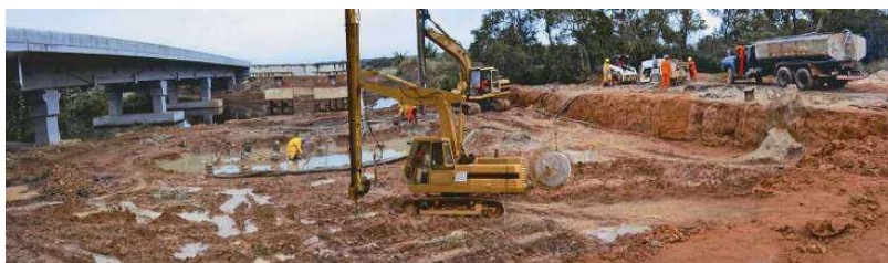
Geoenrijecimento do solo com CPR Grouting na BR-101, Goianinha, RN.
