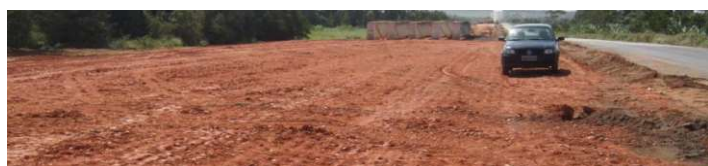
Nova terraplanagem após o CPR Grouting...
