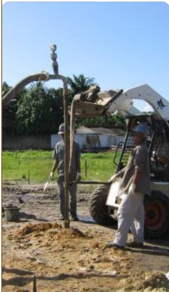
*Cada bulbo de compressão do solo mole é, rigorosamente, controlado através de curvas pressiométricas volume x pressão, previamente estabelecidas pelo programa geotécnico de elementos finitos do projeto de obra com critérios de tensão/deformação.*
