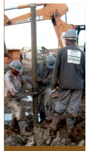
Fazemos o levantamento da poropressão original ao longo dos trechos antes do CPR Grouting. Excesso e dissipação máximos da poropressão são controlados, durante o CPR Grouting, com piezômetros de cordas vibrantes, atestando-se, imediatamente, o grau de adensamento alcançado.
